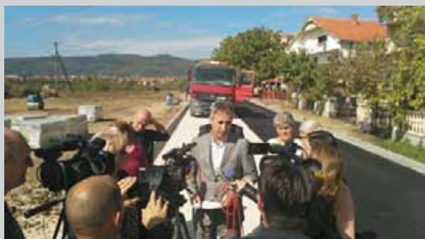
Асфалтирање улице Будислава Шошкића
