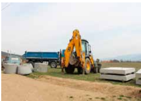
Феанше Д Епера изградња канализационе мреже
