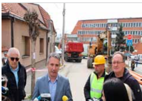
Улица Саве Ковачевића изградња канализационе мреже
